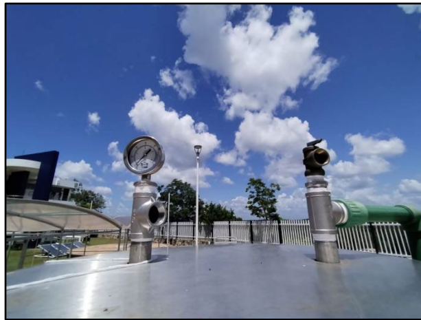
Figura 42. Recuperación de agua en el tanque.
