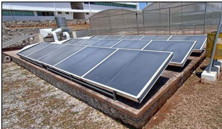
Figura 8. Banco de colectores solares para calentamiento de aire.
