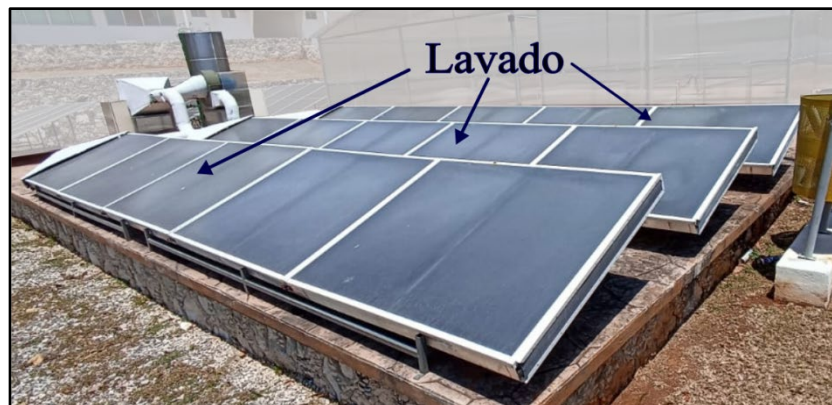
Figura 38. Lavado de colectores solares.
