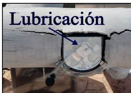
Figura 41. Mantenimiento en manivela.
