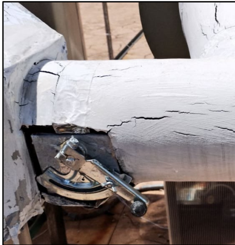
Figura 31. Válvula de acceso de aire desde el intercambiador de calor abierta.
